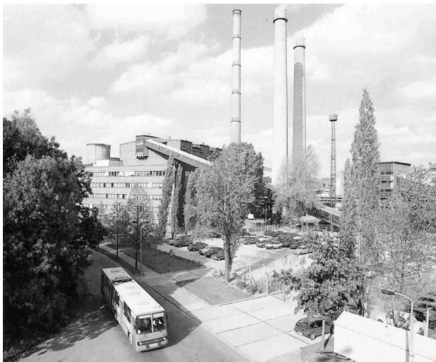
Heizkraftwerk Chemnitz Nord
